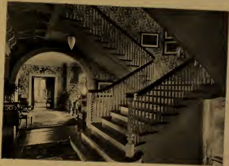
STAIRWAY, RESIDENCE OF A. S. FELLOE, Chillicothe, Mo.
